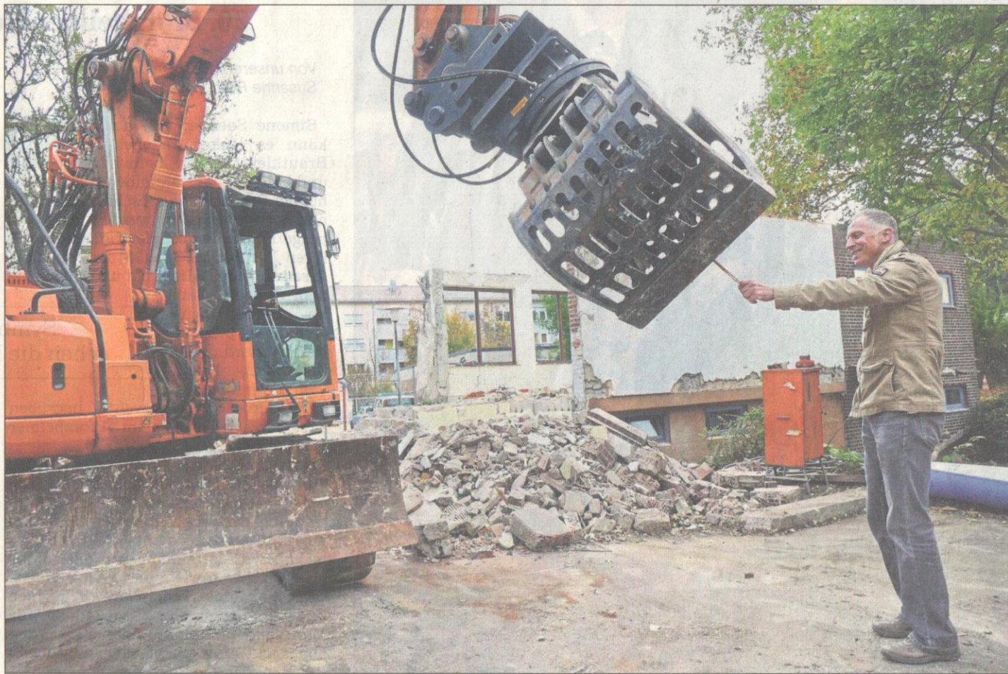
GESTELLTES FOTO MIT SYMBOLWERT: Für die Verkehrswacht-Vorsitzende Daniela Vogel senden Baggerführer Jan Meyer und der „dirigierende“ Bauleiter Joachim Lichter mit diesem Bild ein wichtiges Signal für die Unterstützer des Projekts. Foto: Roth
